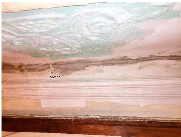
Sl.14 i 15 Dubinska pukotina injektirana je finom viskoznom masom Mapei antik LC . Injektiranje se izvelo pomoću medicinskih šprica, uz prethodno vlaženje žbuke vodom ( kako bi se omogućilo bolje prodiranje injektirne mase.
