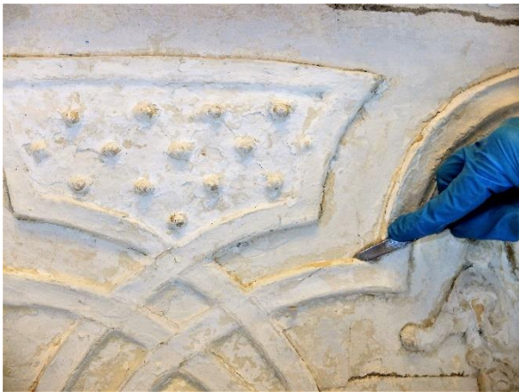
Sl.9 Uklanjanje slojeva naliča sa stropnih štukatura (paper mache) mehanički, kirurškim skalpelima.
