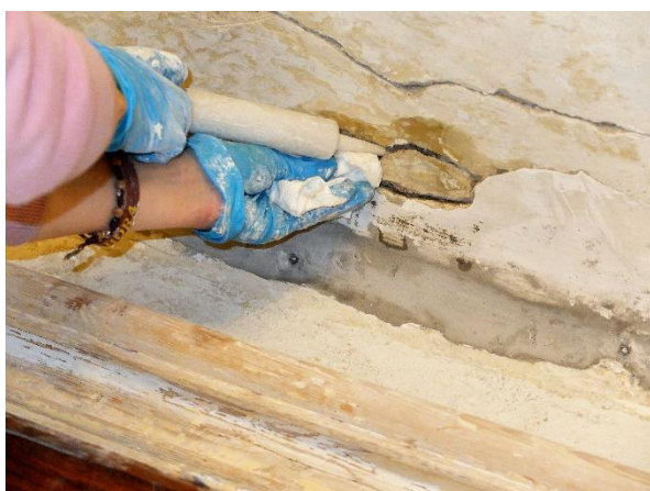
Sl.16 Injektiranje sloja fine žbuke koja se odvojila od osnove.
