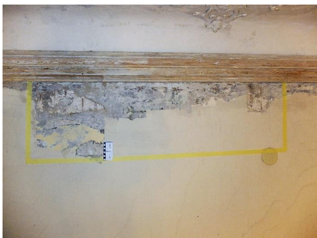
Sl.21 Sonda na bočnom zidu ispod drvenog vijenca.
