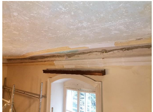
sl.13 Injektiranje dubinske pukotine injektir masom Mapej
