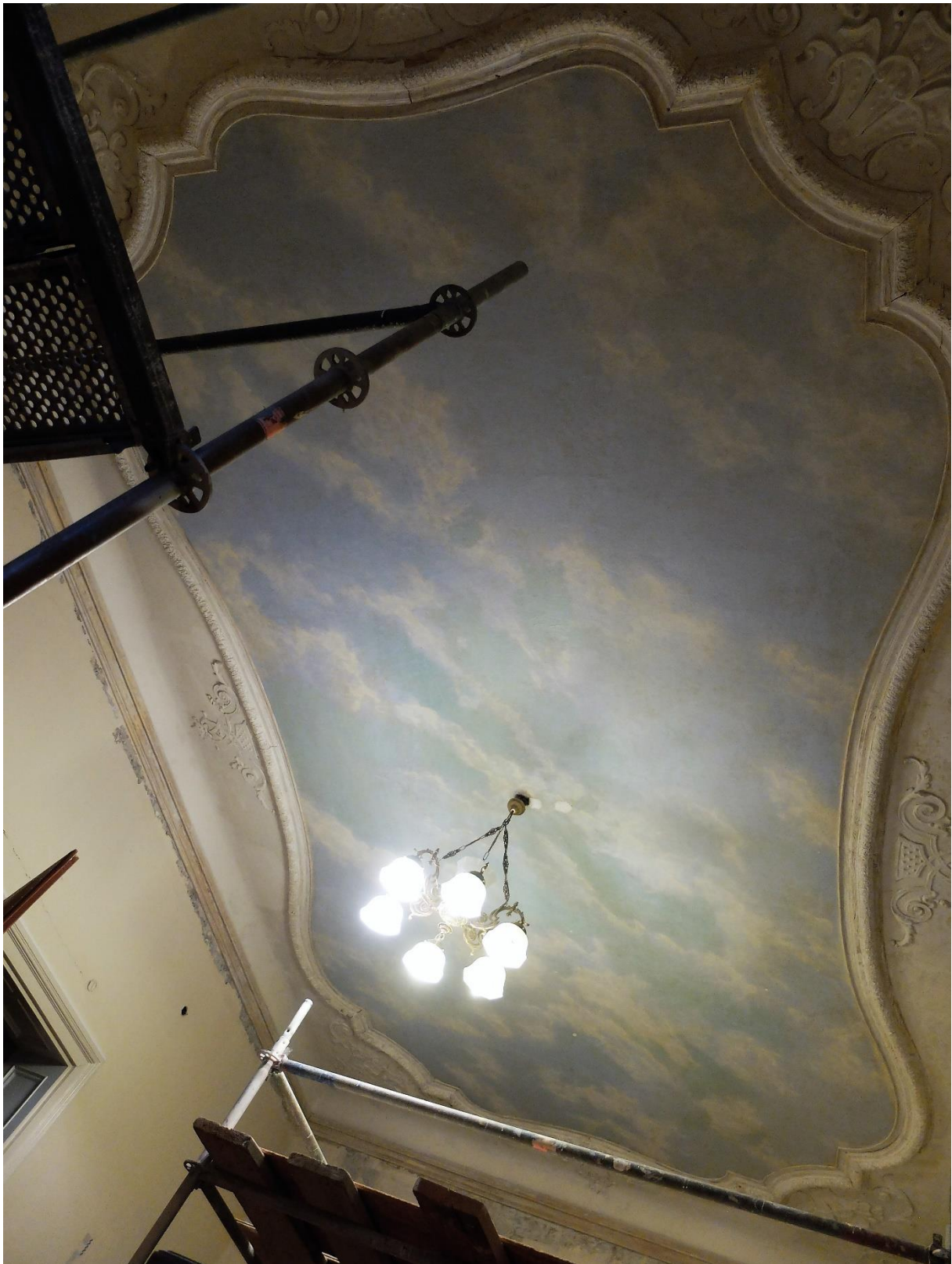
Sl.20 Pogled na strop sobe, nakon izvedenih konzervatorsko restauratorskih radova uklanjanja slojeva naliča sa stropne slike , štuko drvenog okvira, štukatura izvedenih tehnikom kaširanog papira ( paper marche) i drvenog vijenca.
