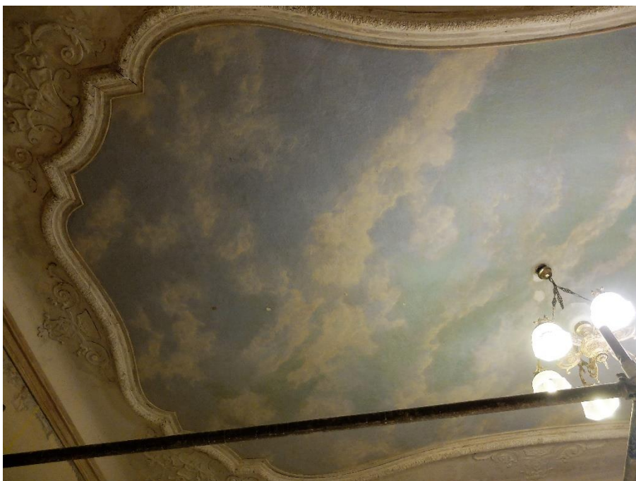
Sl.6 Stropna slika nakon mehaničkog i kemijskog uklanjanja bojanih naliča i sloja žućkaste Prljavštine.
