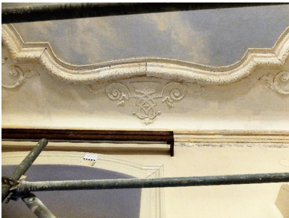
Sl.11 Drveni štuko okvir i štuko dekoracija nakon uklanjanja slojeva naliča.
