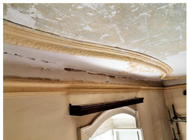
Sl.14 i 15 Dubinska pukotina injektirana je finom viskoznom masom Mapei antik LC . Injektiranje se izvelo pomoću medicinskih šprica, uz prethodno vlaženje žbuke vodom ( kako bi se omogućilo bolje prodiranje injektirne mase.
