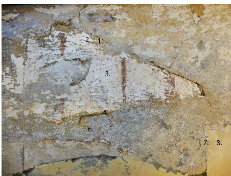
Sl.22 Sonda na bočnom zidu ispod vijenca, detalj.
