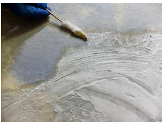
Sl.3 Kemijsko uklanjanje sloja žućkaste prljavštine 5%otopinom Contrada 2000 u sapunici.
