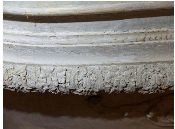
sl.8 Štuko okvir detalj, nakon uklonjenih slojeva naliča
