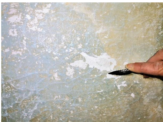
sl. 2 Mehaničko uklanjanje ostataka bijelog naliča sa stropne slike.
