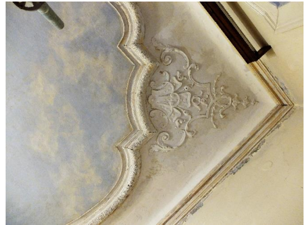
sl.10 Uglovna štuko dekoracija nakon uklanjanja slojeva naliča.
