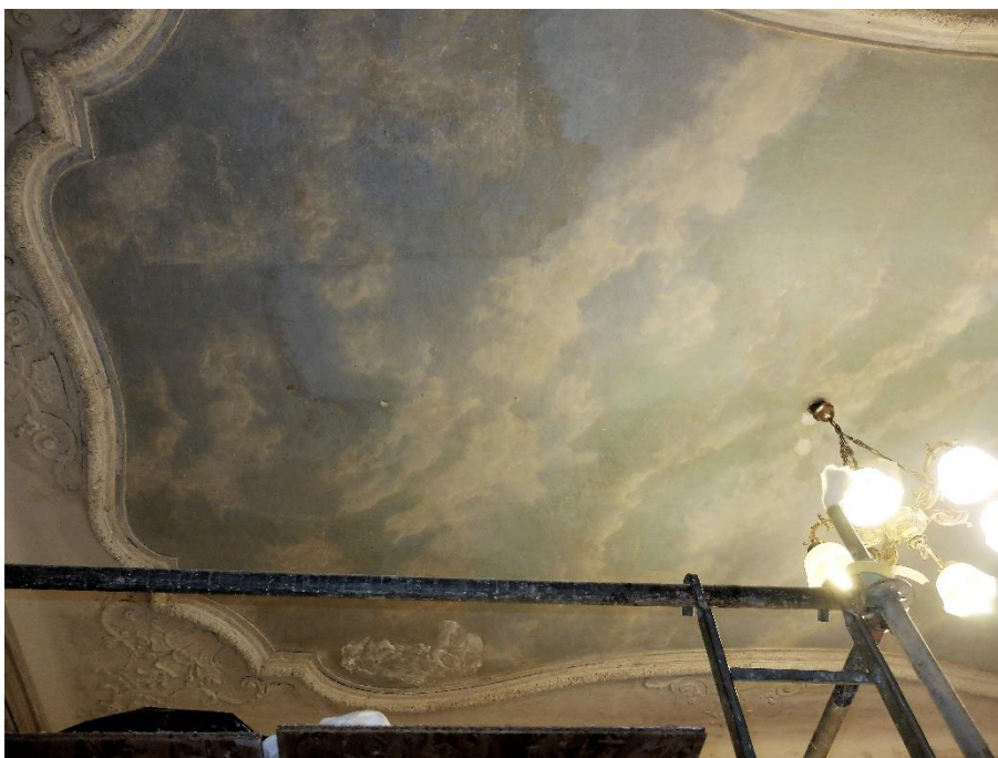
Sl.5 Stropna slika u tijeku uklanjanja žućkastog sloja prljavštine.
