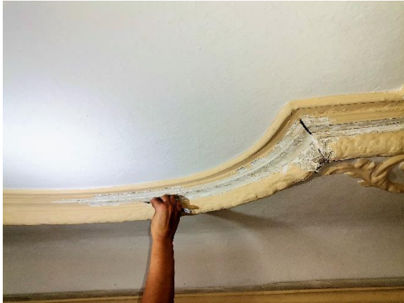
Sl.7 Mehaničko uklanjanje sva sloja naliča sa štuko okvira.
